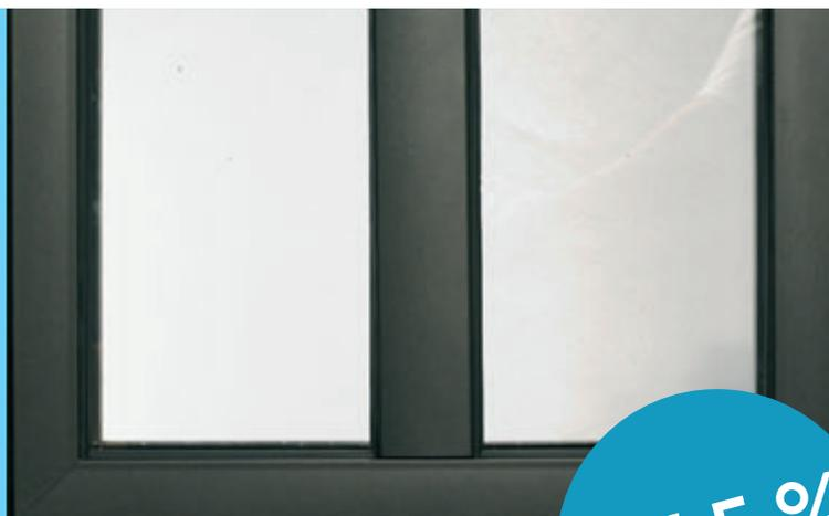
Vue extérieure avec le montant central réduit à 80 mm
